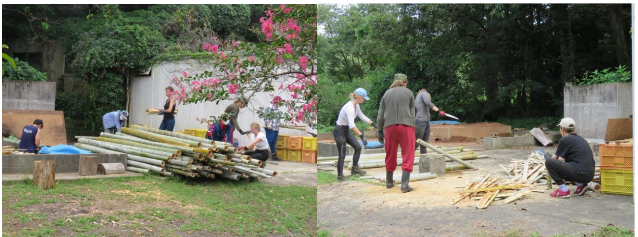
窯に仕込むための竹の玉切りと分割作業
