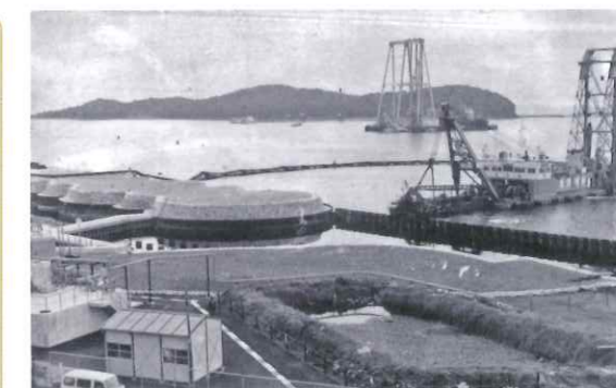
資料⑥ 水俣湾のヘドロ浚渫作業 1983年3月撮影(熊本日日新聞社)
