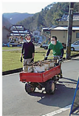
地域のボランティアの方々や職員が、被災されたお宅の土砂出しを行いました
