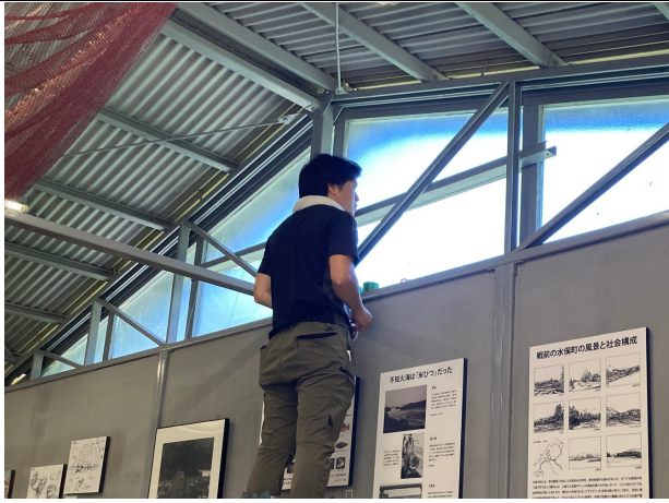
▲ 考証館の窓の紫外線カットシート設置工事
